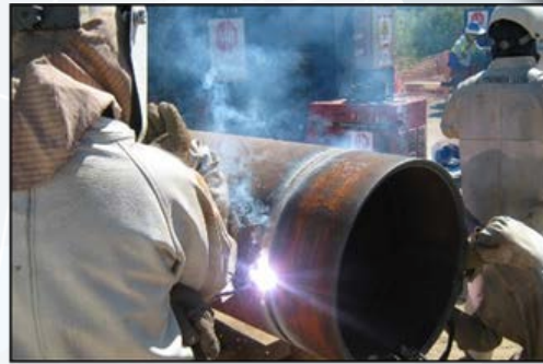
SUPERVISIÓN DE MONTAJES
