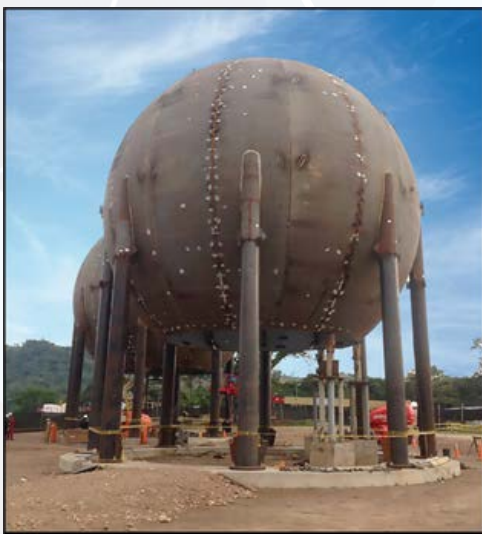
ENSAYO DE EMISIÓN ACÚSTICA PARA LOCALIZAR RAJADURAS EN LA CONDICIÓN DE SERVICIO
