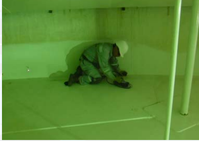
INSPECCIÓN ZONA CRÍTICA TANQUE EN SERVICIO
